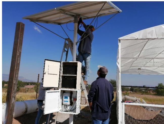
Fig. 5. Instalación del sistema fotovoltaico aislado.
